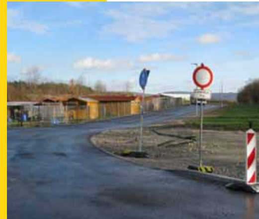
2011 eröffnete neue Bustrasse Masurenstraße – Erschließung Baugebiet Zur Sonne
